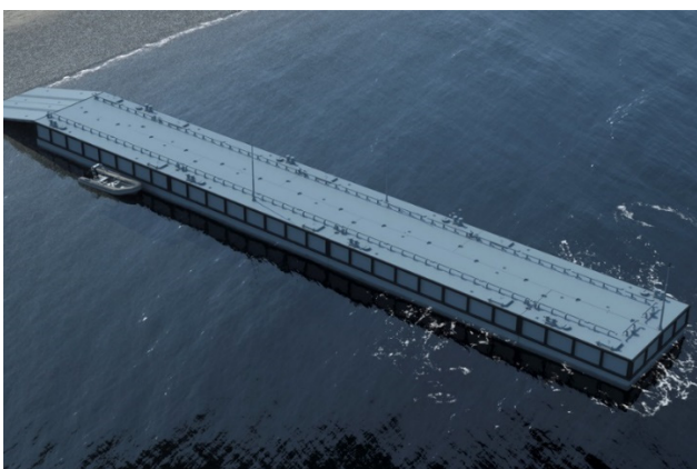
Рис. 3. Быстромонтируемый плавучий причал
